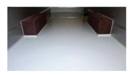
Для заливки пола применяется специально разработанный состав **Kestopur 200/3F**. После полной полимеризации образует прочное, но при этом достаточно эластичное покрытие.
